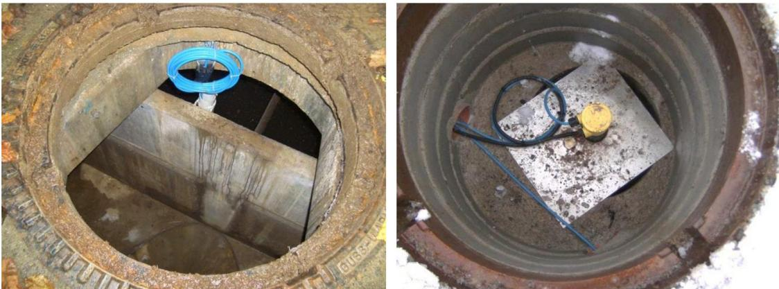
Abb. 17 Verbesserte Zugänglichkeit von Messstellen bei Einbau von außen
