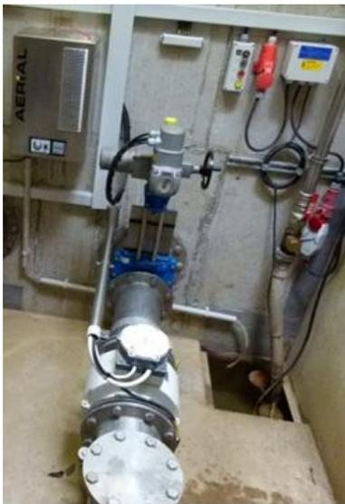
Abb. 18 Mess- und Regeleinheit mit teilgefülltem IDM
