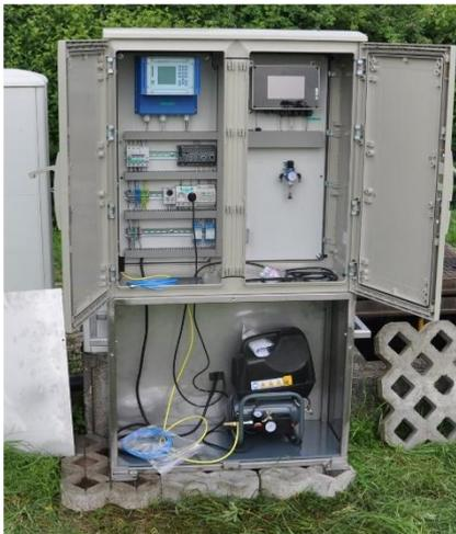
Abb. 20 Oberirdischer Schaltschrank einer Messeinrichtung
