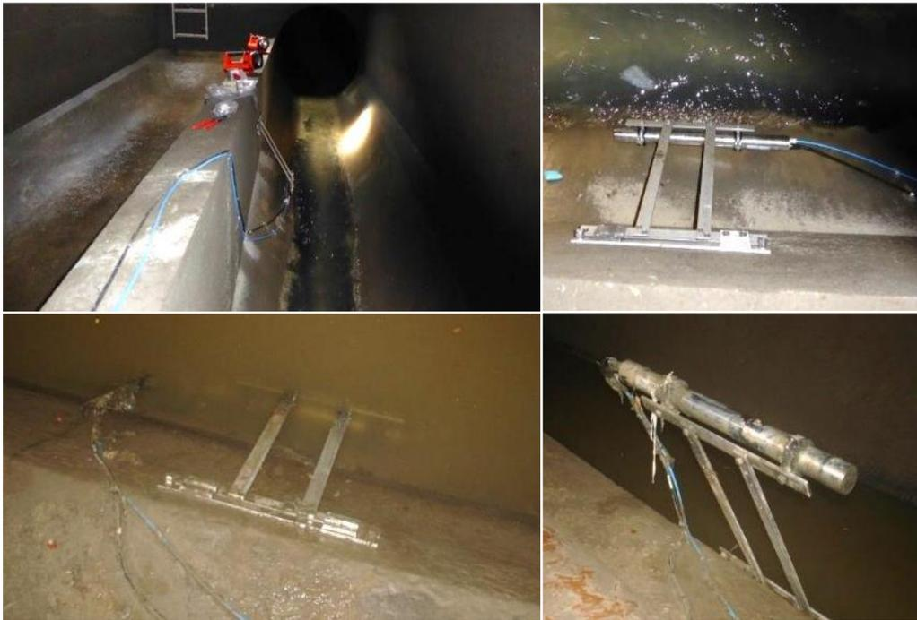
Abb. 21 Temporär (oben) und permanent (unten) eingetauchte Installation einer Spektrometersonde an einer Trennbauwerksschwelle eines RÜB's
