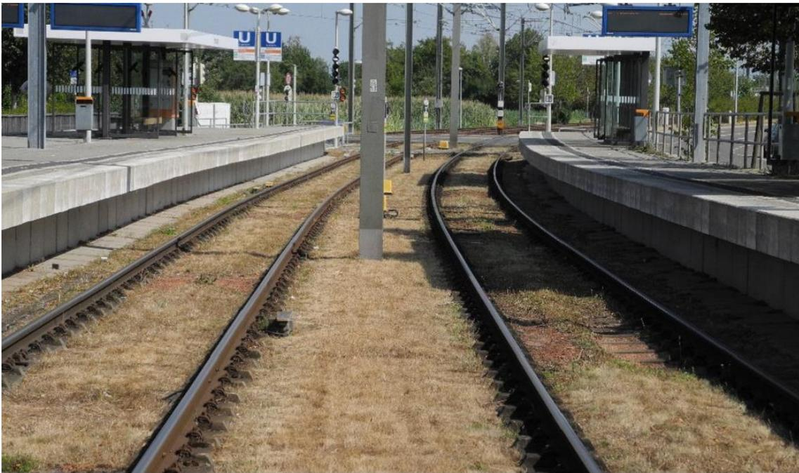
Abb. 1: Begrünte Gleistrasse in Stuttgart August 2015, Foto: Baumüller
