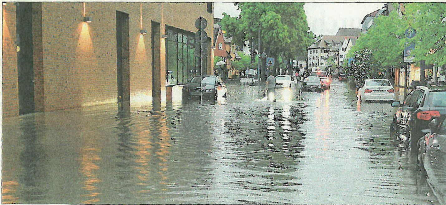
Die Ledergasse liegt am tiefsten Punkt der Altstadt, ihre Kanalisation konnte die Wassermassen nicht mehr fassen. Die Straße, Erdgeschosse und die Keller der Häuser standen nach dem Starkregen vom 29. Mai 2016 unter Wasser.
