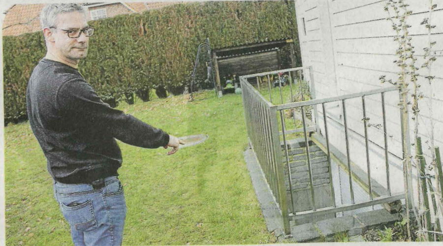
Andreas Schwartzfeldt vor einem der Kellerschächte, in die 2013 das Wasser eingelaufen ist.
