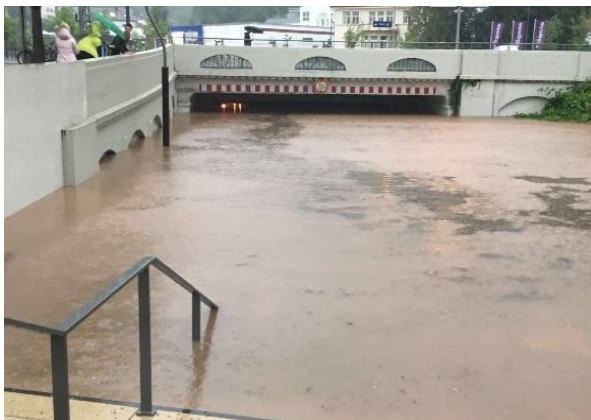
Abb. 1: Überflutete Unterführung am Bahnhof in Schwäbisch Gmünd nach dem Starkregenereignis am 29. Mai 2016.
