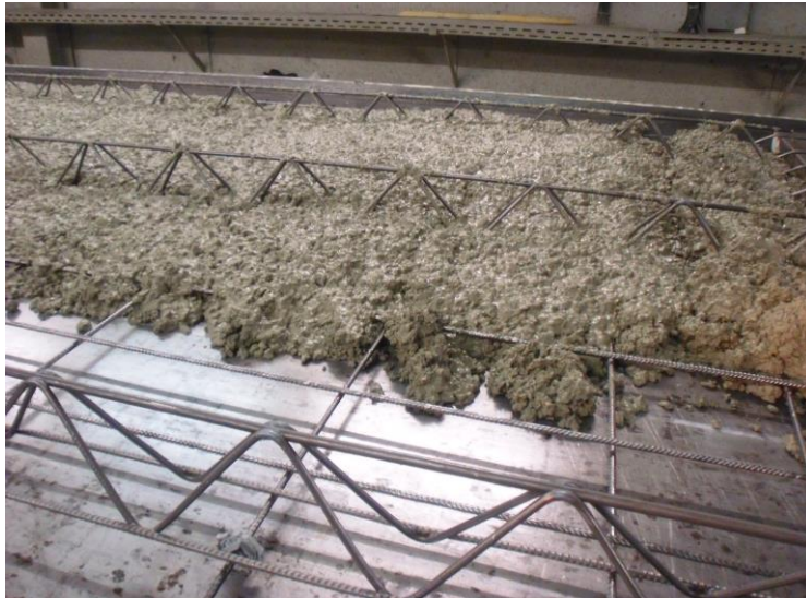
Herstellung der ersten Elementdecke aus Ökobeton im April 2010
